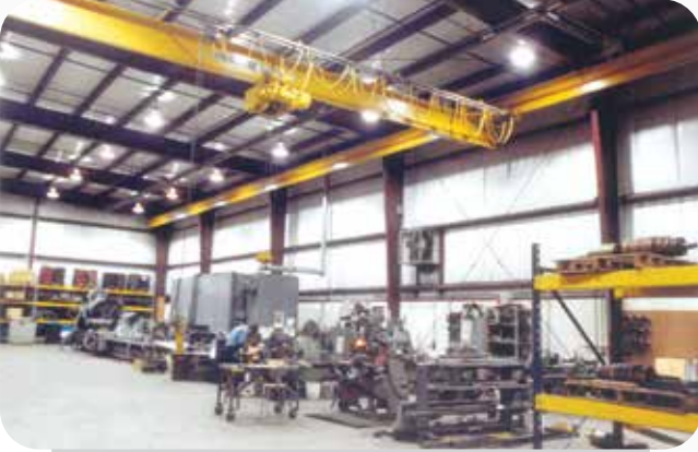
Fabrika Uygulaması: Seri Yakıclı Sistem - Genel Isıtma
